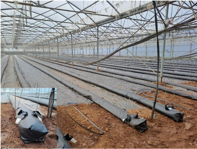
Installation des gaines de Thermitube fin janvier. Deux systèmes de fermeture aux extrémités : pinces à gauche ou coude à 90° à droite
