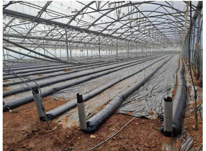
Installation des gaines de Thermitube fin janvier. Deux systèmes de fermeture aux extrémités : pinces à gauche ou coude à 90° à droite
