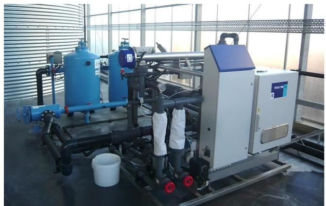
Figure 4 : Installation dernière génération pour la désinfection par ultra-violet, constructeur PRIVA (2013)
